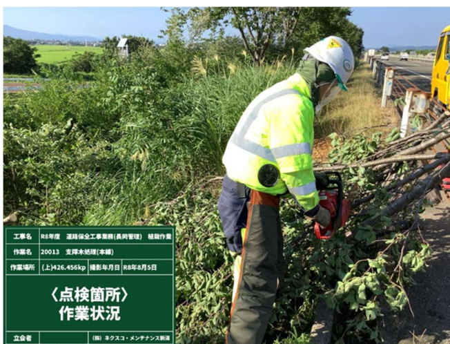
写真－４ 支障木の伐採
