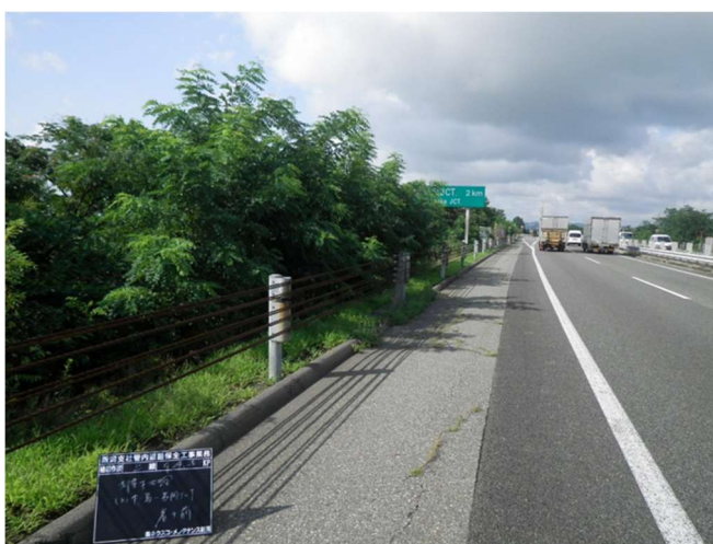
写真－２ 支障木による標識類の視認性低下
