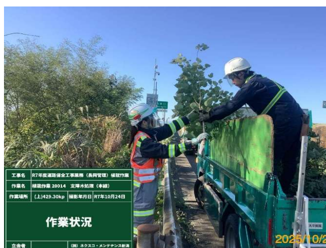
写真－５ 運搬車両への積込
