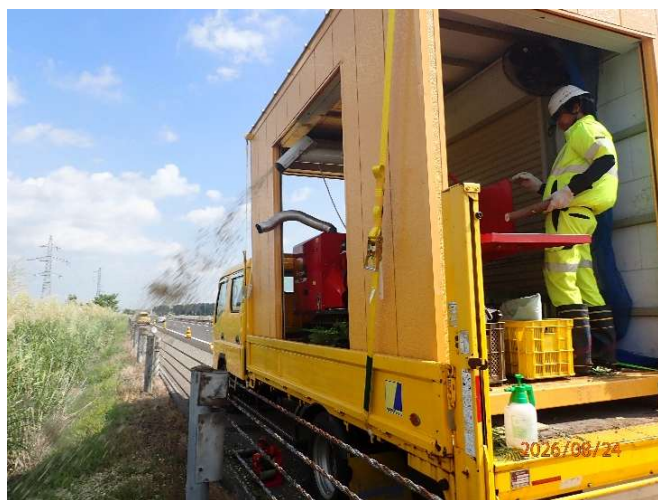
写真－８ 木材破碎機による吹き付け
