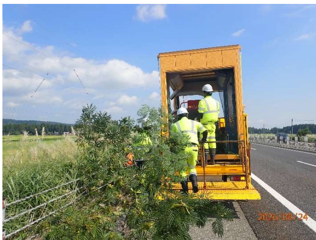
写真－６ 伐採した支障木を現地でチップ化
