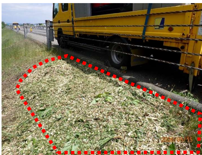
写真－９ 本線のり肩部吹き付け状況
