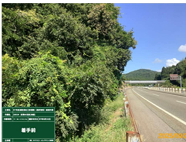
写真－１ 枝葉の張り出し支障木
