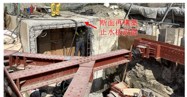
図-3 既存地下道側壁との接続部
