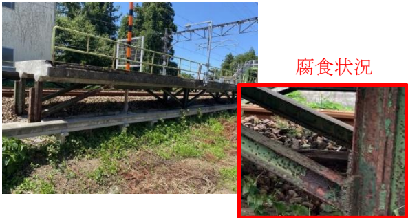
写真-1 対象ホーム桁
