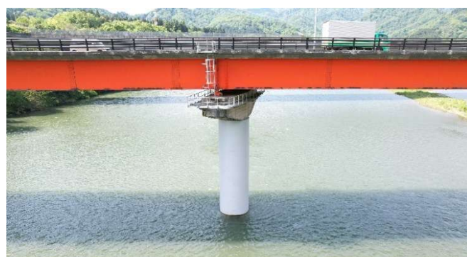
写真-3 工事完了 (P2 橋脚)
