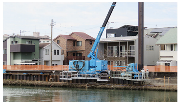
図 3. 圧入工法の施工 3)
