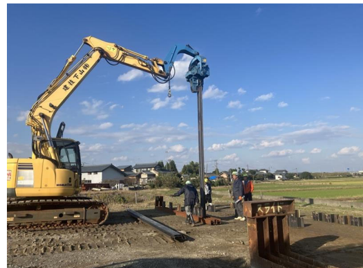
図 2. バイブロハンマ（LHV）工法の施工
