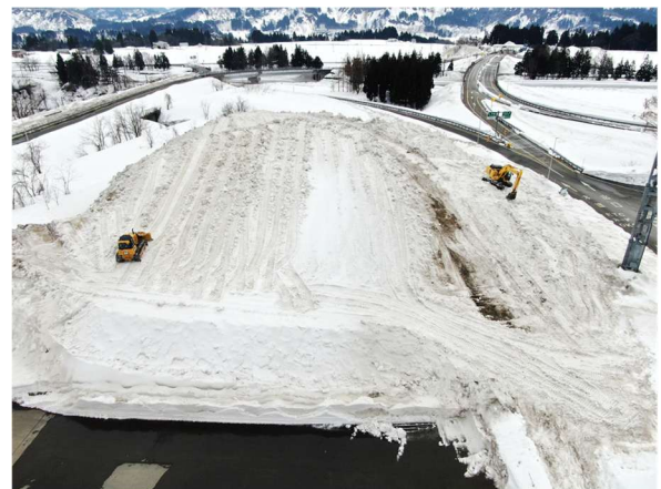
図-2 雪捨て場に除排雪が集積されている状況（関越自動車道 越後川口SAの雪捨て場）
