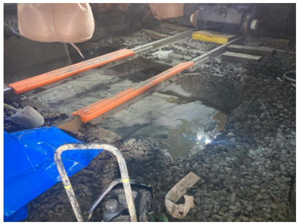
図 5 路盤材の敷設状況
