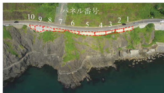
図-1 対象とした RC 道路擁壁
