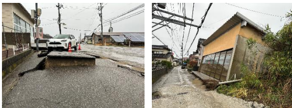
(a) 地盤の沈下 (b) 建物の倒壊
