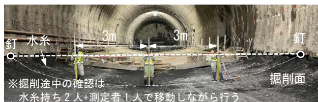
写真-1 従来方法による掘削出来形管理（掘削後）
