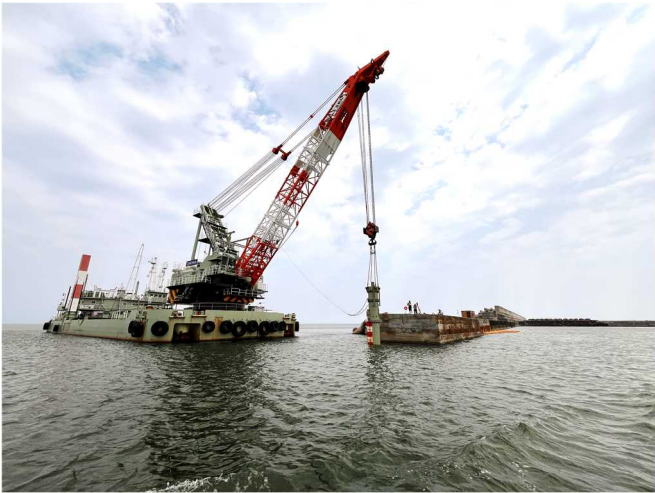
図-3 機械均し施工状況
