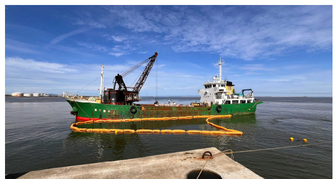
図-1 捨石投入状況
