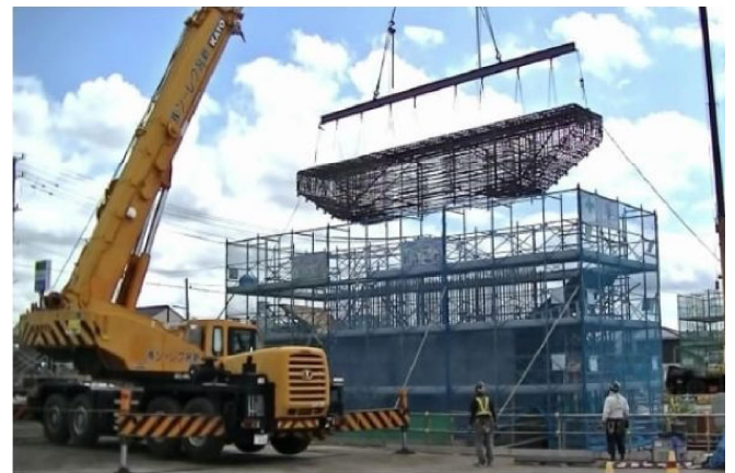
写真-3 プレハブ鉄筋据付状況
