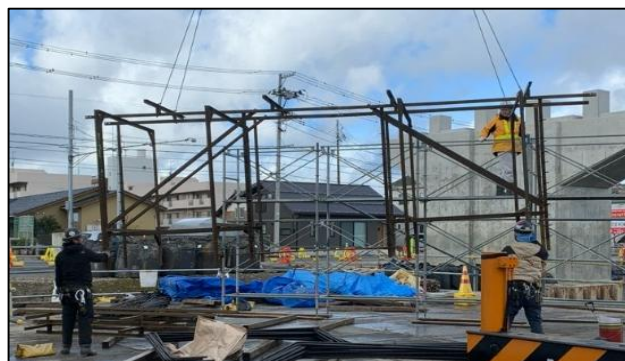
写真-1 架台組立状況
