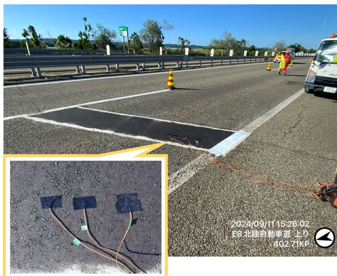
図-4 熱電対による路面温度測定状況
