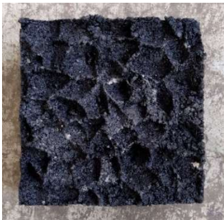
写真-2 供試体の下面の状況（バラスト側）
