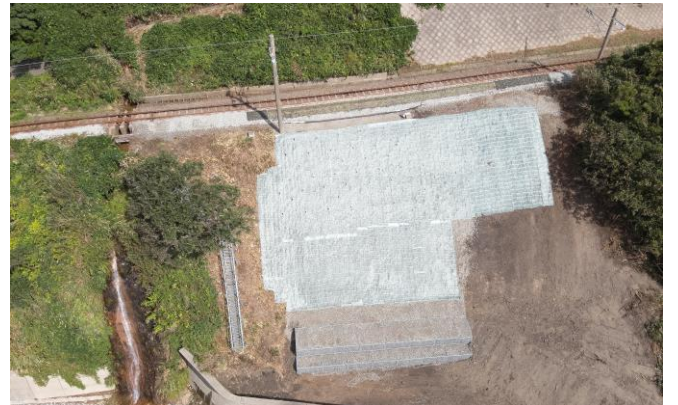
写真-2 復旧状況
