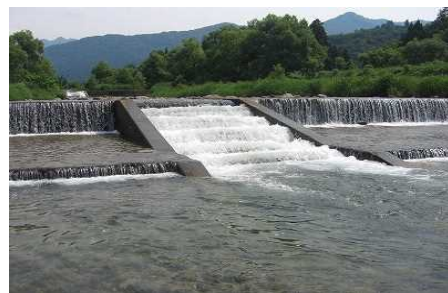
図2 水路階段式魚道
