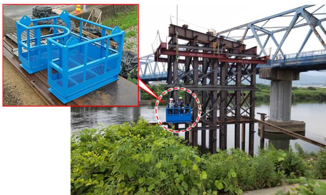
図5 搭乗設備活用による下部工施工状況
