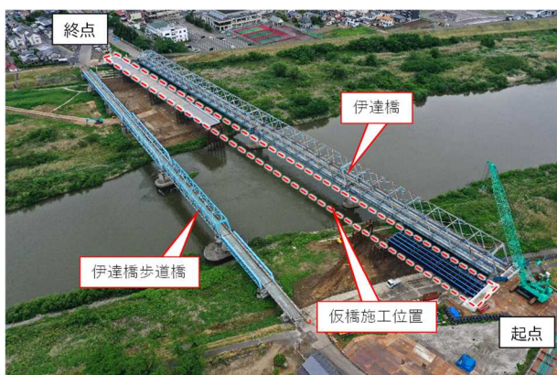
図1 施工箇所（着手前）
