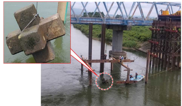
図6 六脚ブロック撤去状況
