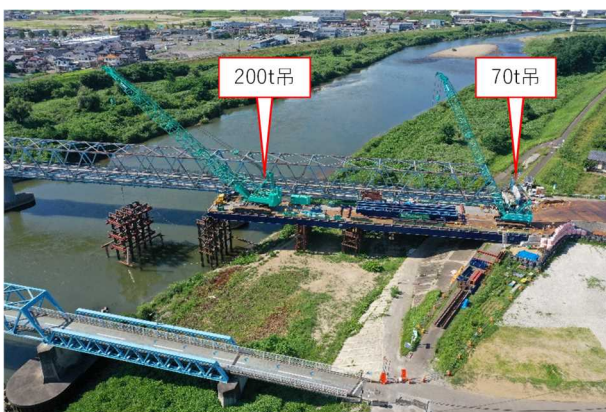
図4 クレーン2台体制での施工
