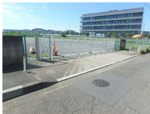
写真-3 既設の乗り入れ構造
