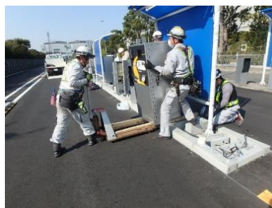
写真-2 料金所付近の撤去・復旧工事
