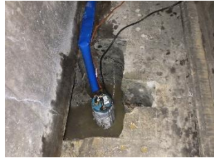
写真-5 試掘箇所全景
