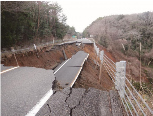
図 1 2024 年能登半島地震後ののと里山海道（横田 IC～徳田大津 IC）の被害
