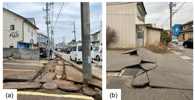
図-2 西区寺尾周辺で確認された(a)県道16号線付近の滑り (b) 県道16号線よりも南側の低地領域で確認された舗装の隆起
