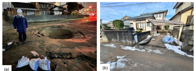
図-3 (a) 西区ときめきで確認された直径2m、深さ70cmの噴砂孔 (b) 建物の不同沈下
