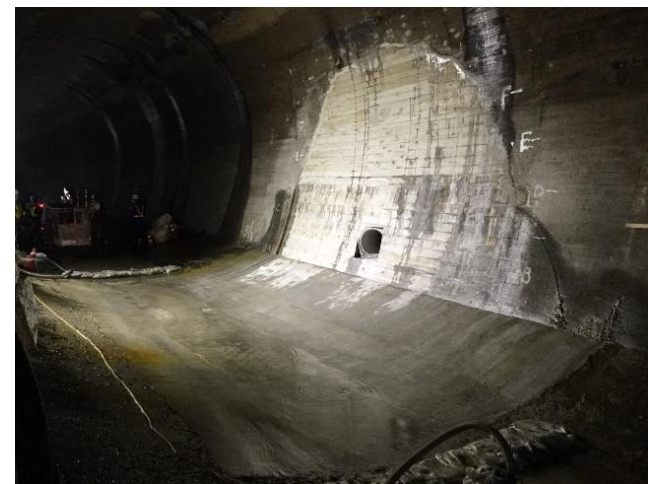
図-17 横坑復旧完了
