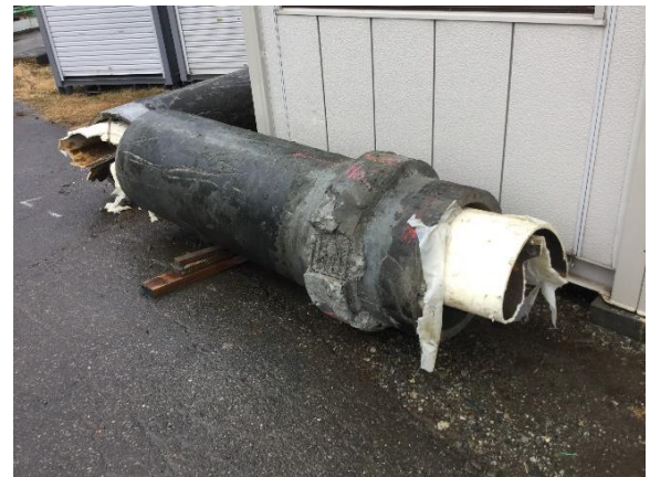
図-9 既設ヒューム管
