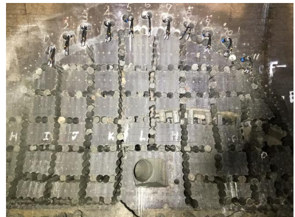
図-14 鏡切り工施工後
