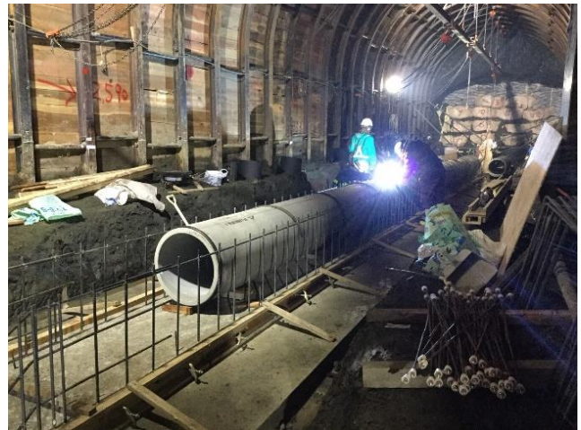
図-15 送水管設置作業
