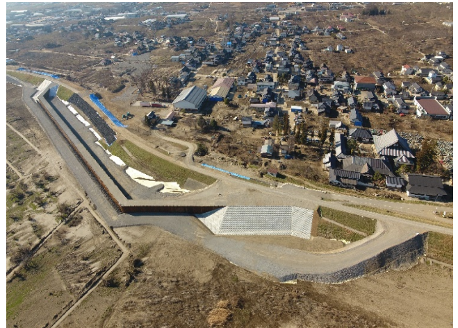
写真—1 千曲川堤防決壊部完成
