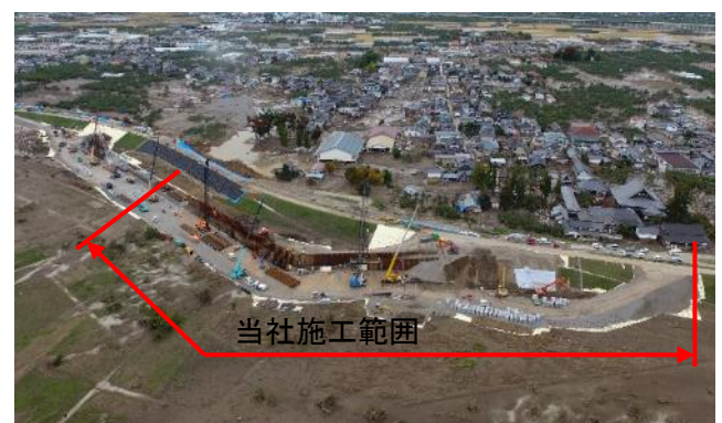
写真—2 10月24日 施工状況 ※右側護岸ブロックから中央部までが当社施工範囲
