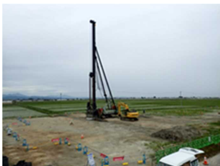
写真-1 施工状況全景
