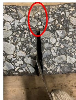
写真-5 き裂の状況
