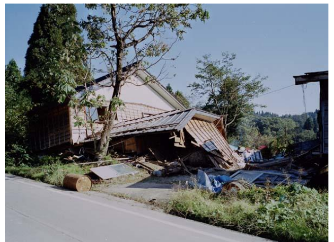
図-2 武道窪地区における家屋被害 2)
