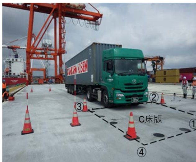
写真-2 動的載荷試験実施状況
