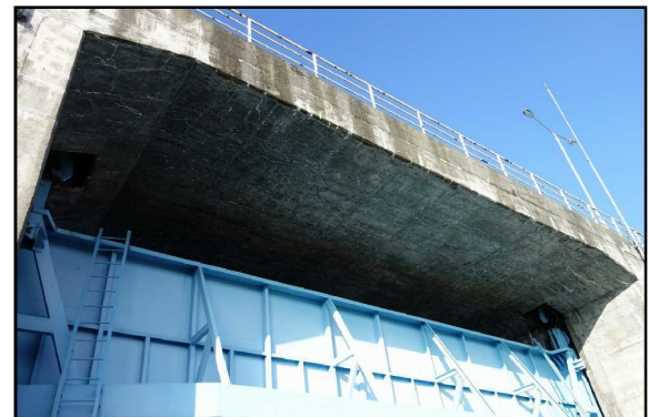
写真-3 新黒川水門頂版下面
