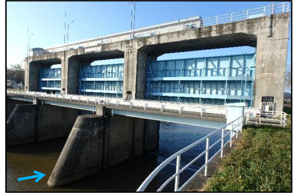
写真-1 新黒川水門全景（上流側）
