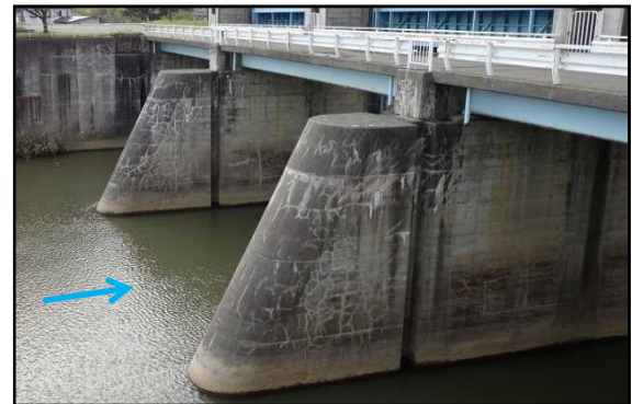
写真-2 新黒川水門堰柱
