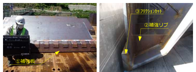
写真-4 刃先先端の補強
