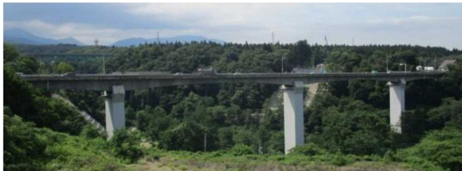
写真-1 妙高大橋（現橋）
