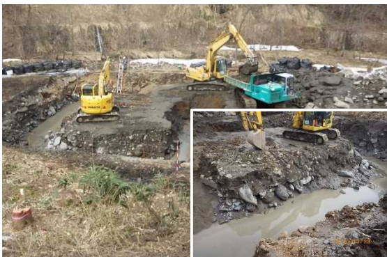
写真-3 ケーソン刃先下の先行碎石置換
