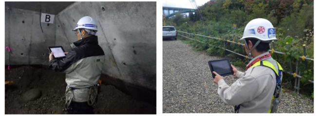
(a)圧気作業室内 (b)現場の外(夜間・休日も可)
