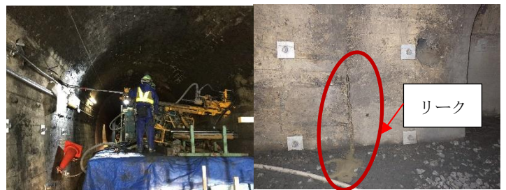
写真2 ロックボルト施工時状況
