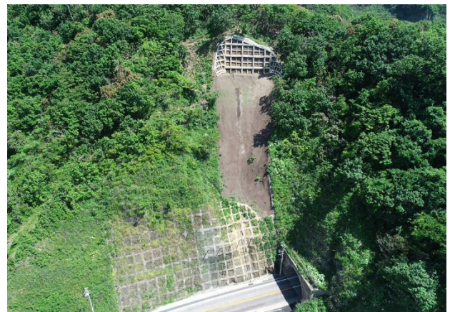
写真 4. 恒久対策後の崩壊斜面
