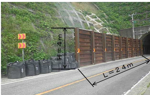
写真 3. 応急復旧工事で設置した仮設防護柵
