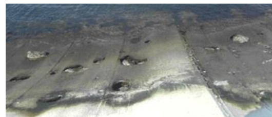
図-15 防砂シートに孔が空いている様子
