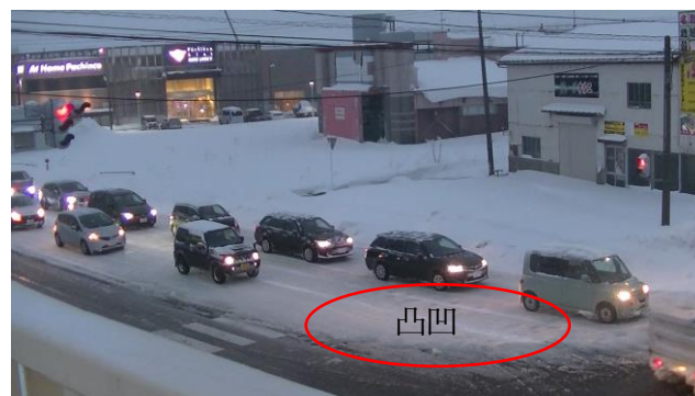
図6 要町一丁目の圧雪の凸凹状態
