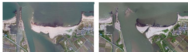
写真-1 フラッシュ前後の砂州形状の変化 左: 出水前 2018年4月27日 右: 出水後 2018年5月21日 国土交通省北陸地方整備局羽越河川国道事務所提供
