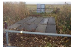
図-4 橋全体の写真
