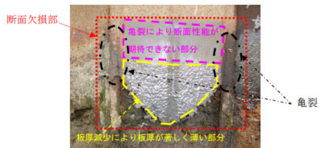
図2.断面欠損と判断する板厚状況(例) 3)
