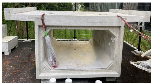
図2 箱桁型供試体
