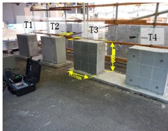
図-1 型枠解体後の試験体の様子
