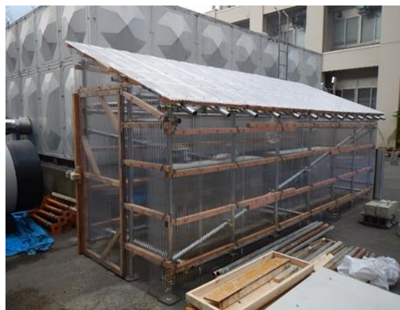
図-3 小屋による囲い状況
