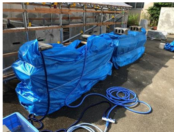
図-2 湛水・湿润養生状況
