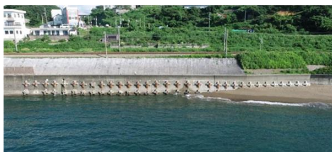
図4. 受圧板設置区間
