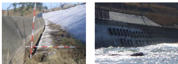
写真1 A地点護岸壁傾斜（左）と受圧板設置（右）
