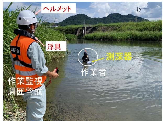
図-13 水深地形把握状況（測深器による計測）
