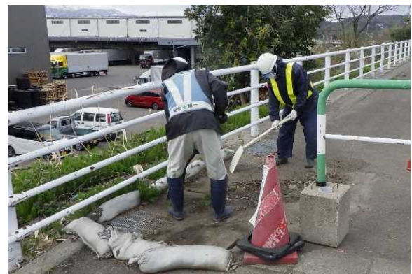
写真-8 人力作業 (土砂・目地撤去)
