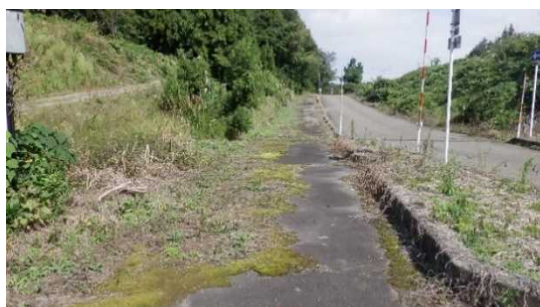
写真-1 土砂撤去前状況 (国道18号)
