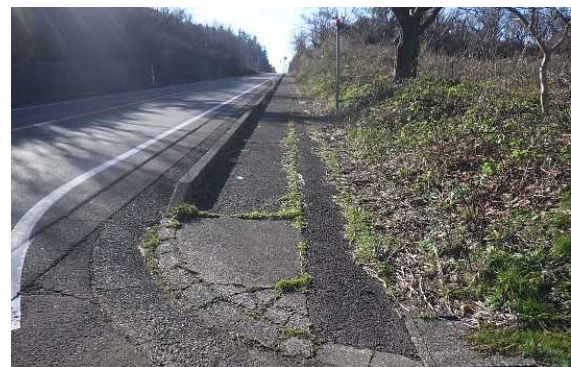
写真-7 平成31年 清掃前 (2年経過後)
