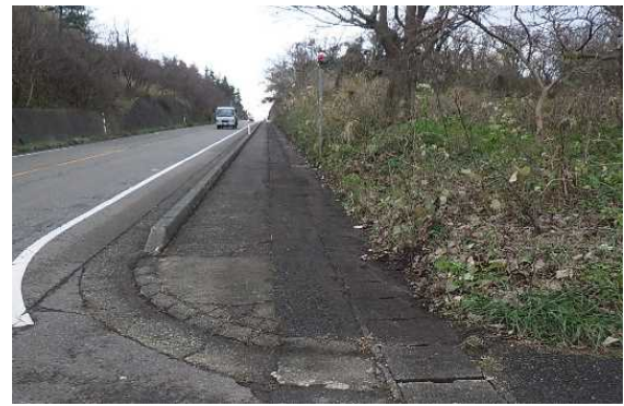
写真-6 平成29年 清掃完了後 (BH+人力)
