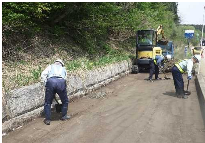
写真-4 人力作業による撤去状況
