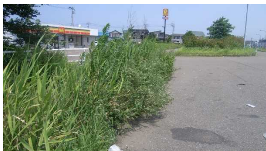
写真-2 土砂撤去前状況 (国道8号)
