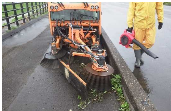
写真-10 清掃状況
