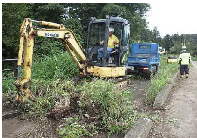
写真-3 堆積土砂の撤去状況
