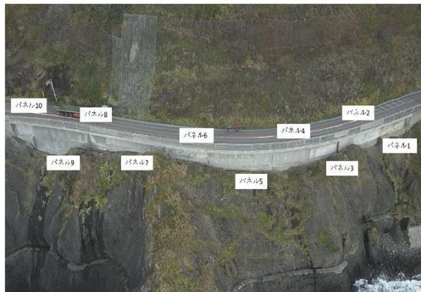
図1 UAV撮影を行ったコンクリート擁壁
