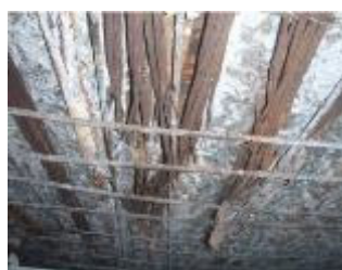
写真-1 第1径間の破断状況
