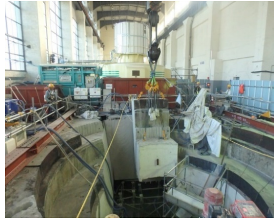
写真 3 切断ブロック撤去状況
