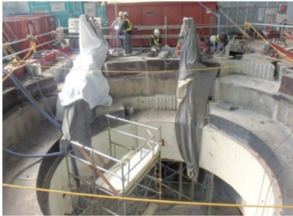
写真 2 ワイヤソー切断状況
