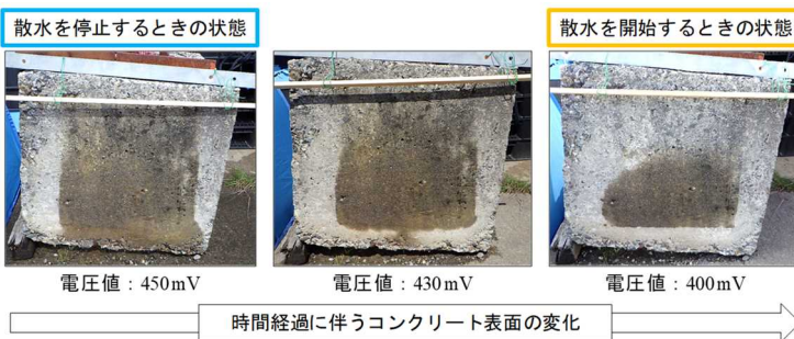
図6 コンクリート表面の目視観察
