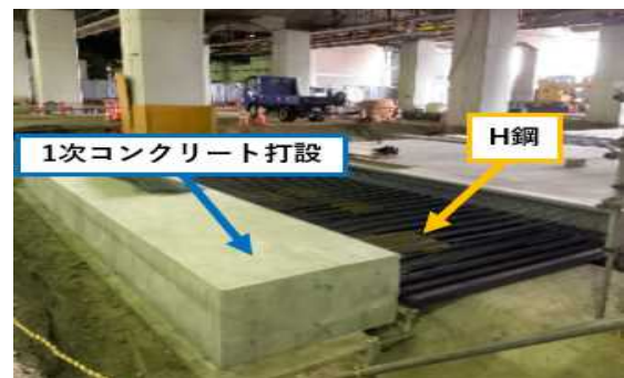
図-5. 1次コンクリート打設・H鋼設置
