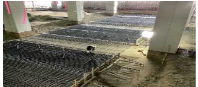
図-4. 鉄筋組立の様子
