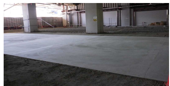
図-7. フラットスラブの完成写真
