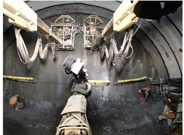
図-1 爆薬の装薬作業
