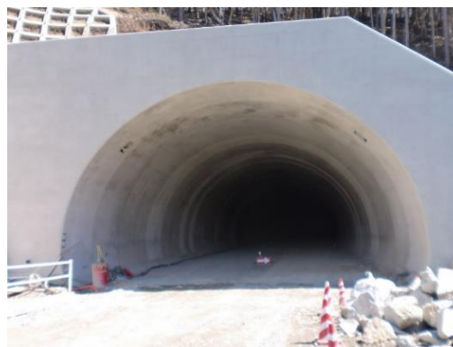
写真-1 NATMの山岳トンネル
