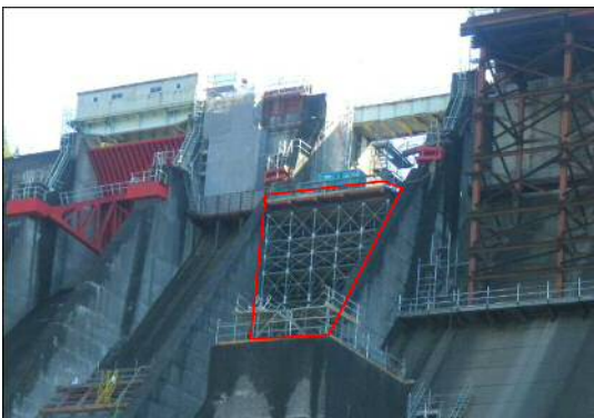
写真-1 パイプ支柱式支保工
