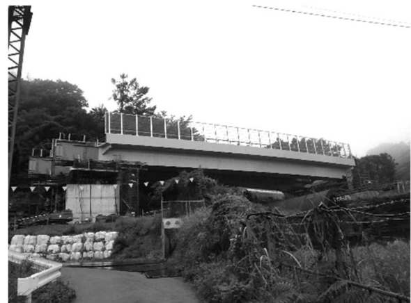
図-10 架設完了後の状況
